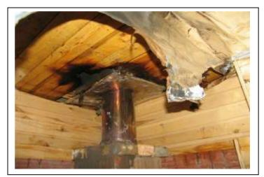
происходил перегрев, рекомендуется часто поливать раскаленные камни водой. Дверь топки должна быть закрытой. Необходимо своевременно очищать печь и вентиляционные каналы от сажи.
