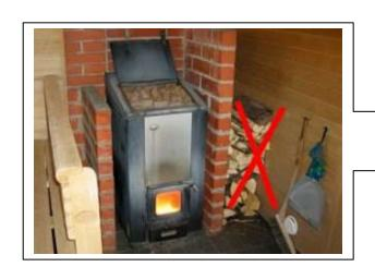
При строительстве печи для бани необходимо учитывать два обстоятельства: древесина может воспламеняться при +300°, пиролиз с последующим возгоранием происходит при длительном
