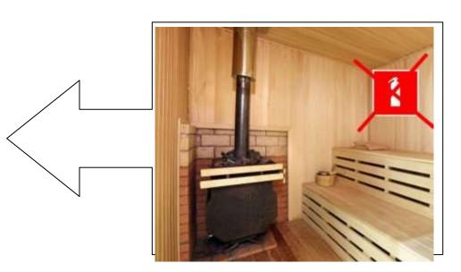
обладать камни, которые кладут сверху. Патрубок дымохода не должен накаляться до красного свечения (свыше 600°). Стены и потолок в местах соприкасания с печью оборудуют термостойкими материалами, например, обшивают стальным листом.
